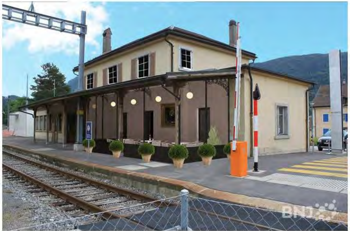
Le futur restaurant de la gare de Travers.
